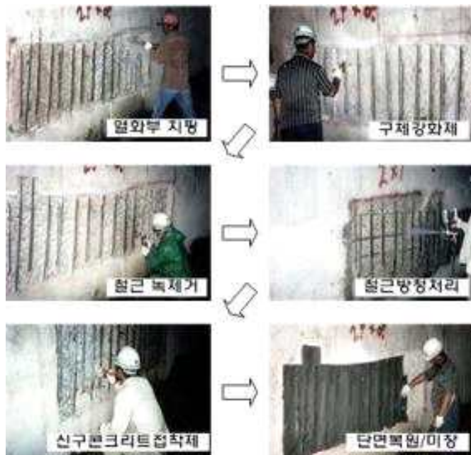
<그림 7.3.10> 단면복구공법(철근방청포함) 개요도
